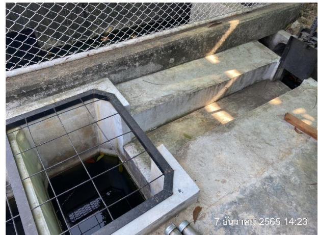
รูปที่ 2.2-51 ประตูละบายน้ำควบคุมอัตราการระบายน้ำออกจากบ่อตกตะกอนก่อนระบายลงสู่แม่น้ำป่าสัก
