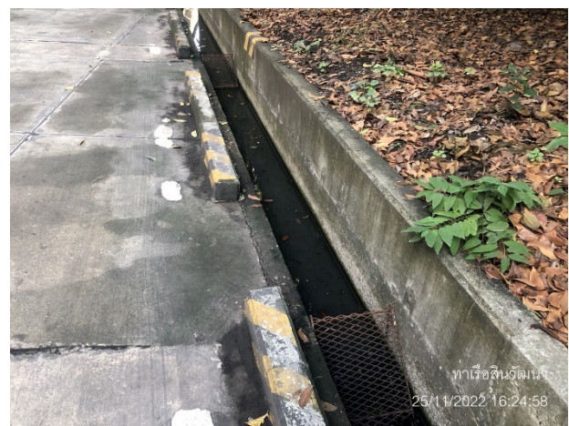
รูปที่ 2.2-52 ตะแกรงดักขยะบริเวณรางระบายน้ำเป็นระยะภายในพื้นที่โครงการ
