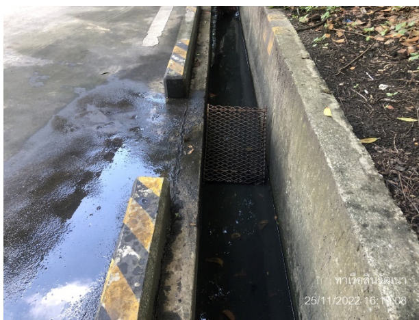
รูปที่ 2.2-52 ตะแกรงดักขยะบริเวณรางระบายน้ำเป็นระยะภายในพื้นที่โครงการ
