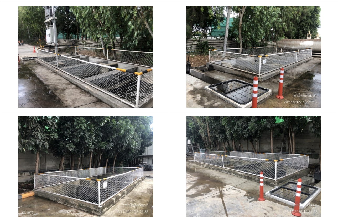
รูปที่ 2.2-50 บ่อตกตะกอน จำนวน 2 บ่อ ภายในพื้นที่โครงการ
