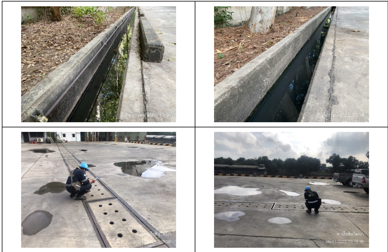
รูปที่ 2.2-49 ระบบระบายน้ำและการทวงน้ำด้วยรางระบายน้ำ ของโครงการ
