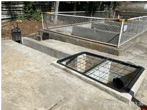
รูปที่ 2.2-51 ประตูละบายน้ำควบคุมอัตราการระบายน้ำออกจากบ่อตกตะกอนก่อนระบายลงสู่แม่น้ำป่าสัก
